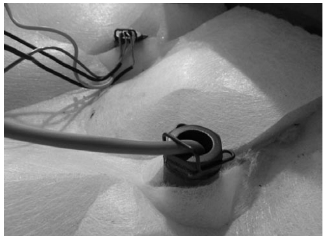
Abb. 16 - Ansicht auf Wassertemperaturfühler TV im Schutzrohr des Kessels Typ DxxP
