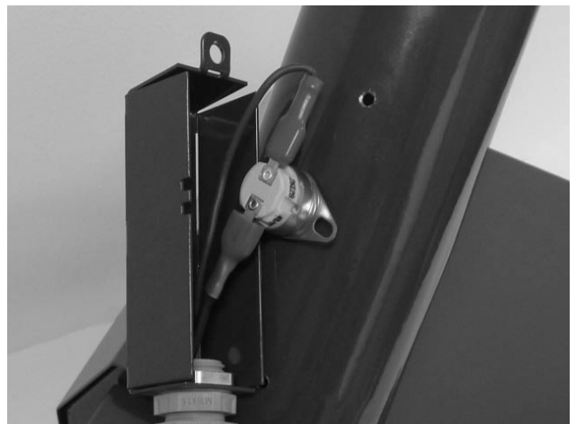
Abb. 10 - Sicherheitsthermostat am Rohr für Pelletzufuhr 95°C
