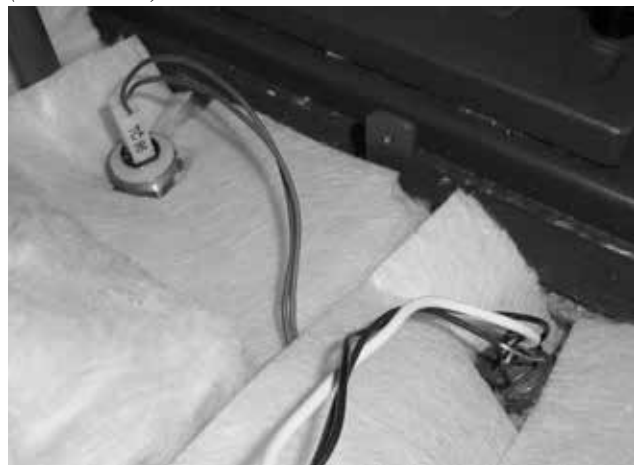
Abb. 16 - Ansicht des Wassertemperaturfühlers TK im Schutzrohr des Kessels DCxxGSP
