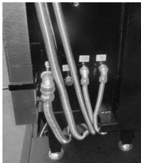
Beispielhafte Rohrverlegung mit flexiblen Schläuchen
