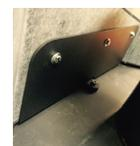
**7:** Placez la pierre contre la plaque métallique afin que ses trous se trouvent en face des trous de la pierre. Fixez ensuite la pierre avec les boulons fournis à l'aide d'une clé (à cliquets) 10mm.
