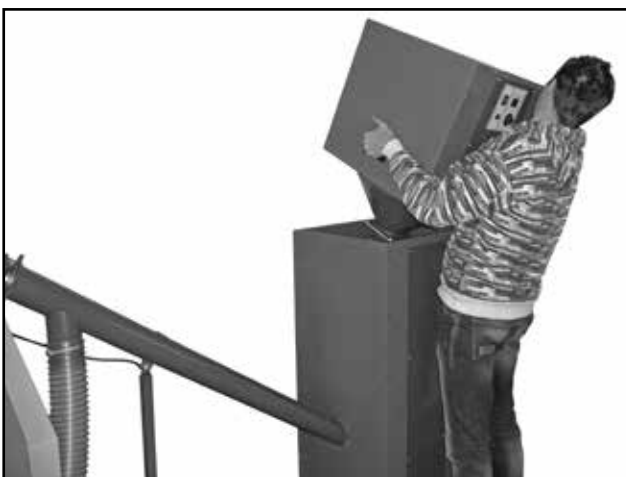
Abheben der pneumatischen Förderanlage vom Ausgleichbehälter
