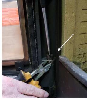
Den Stift entfernen und die Schraube anziehen (Uhrzeigersinn) je nach dem wie schnell die Tür zugehen soll.
