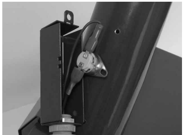
Abb. 10 - Sicherheitsthermostat am Rohr für Pelletzufuhr 95 °C
