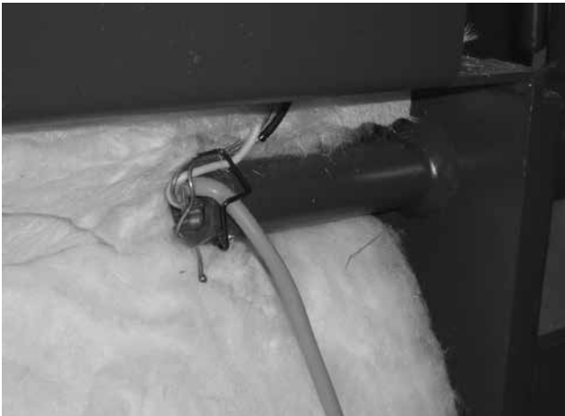
Abb. 15 - Ansicht des Wassertemperaturfühlers TK im Schutzrohr des Kessels mit dem Brenner in Obertür DCxxS(X), CxxS, ACxxS, DCxxRS
