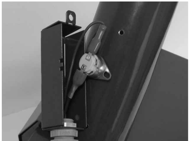
Abb. 10 - Sicherheitsthermostat am Rohr für Pelletzufuhr 95°C
