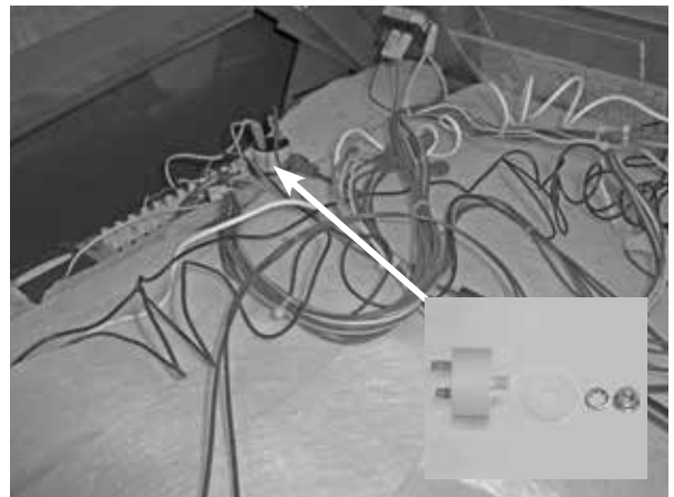
Kondensator für Abzugventilator - 1µF
