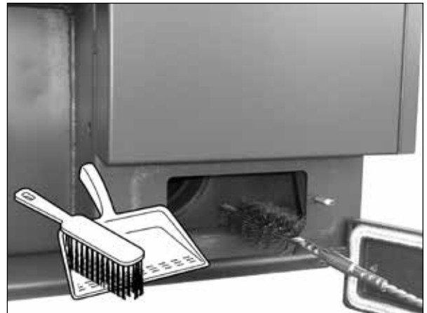
Vorführung der Reinigung des Rauchkanals mit Drahtbürste.
