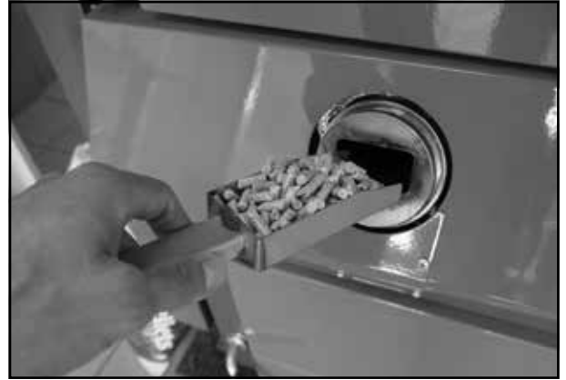
Die Zündkammer mit Pellets zur Entzündung befüllen
