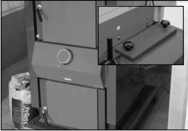
Alle Türen und Reinigungsöffnungen geschlossen
