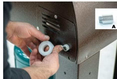
**1.** Isolieren Sie den Gasanschluss des Ofens mit Teflonband (A) und schrauben Sie das Verbindungsstück an.
