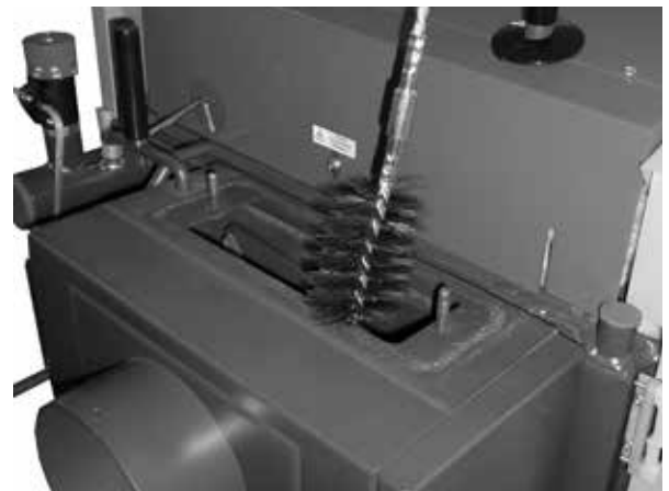
Vorführung der Reinigung des Rauchkanals mit Drahtbürste.
