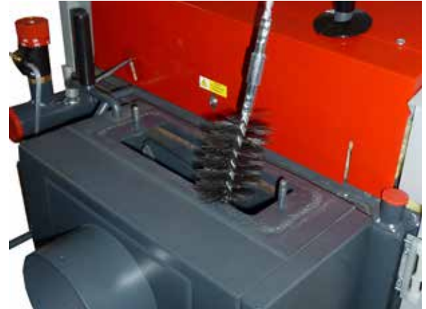
Vorführung der Reinigung des Rauchkanals mit Drahtbürste.
