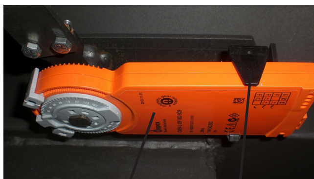
Moteur de commande Patte de maintien moteur
