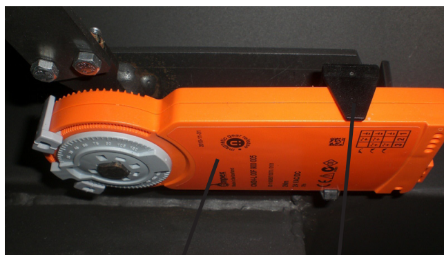
Servomotor Klembeugel van kunststof
